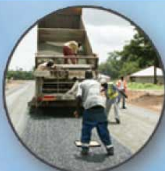
Aménagement de chaussées
